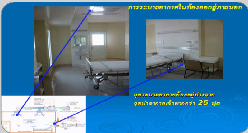
ภาพที่ 5 การควบคุมทิศทาง การไหลของลมภายในห้อง (สถาบันบำราศนราดูร, 2552)
