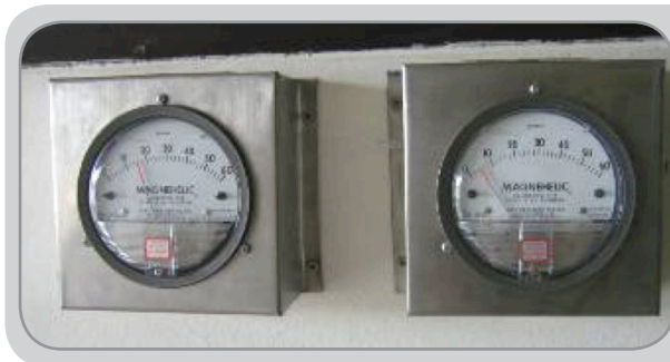
ภาพที่ 14 เครื่องวัดความดันภายในห้องแยกโรคที่ติดตั้งไว้หน้าห้อง
