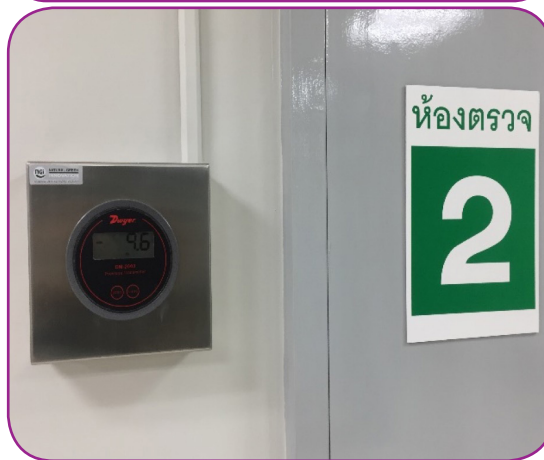
ภาพที่ 14 ตัวอย่างการควบคุมแรงดันภายใน ห้องตรวจให้น้อยกว่าพื้นที่โดยรอบ
